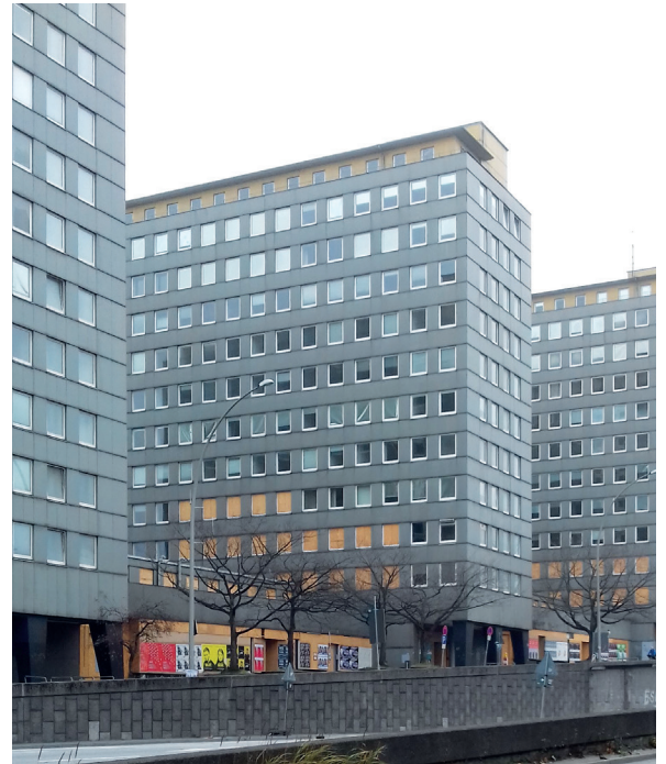
Der City-Hof Komplex in Hamburg: Denkmalschutz 2013, Abriss 2019/20
