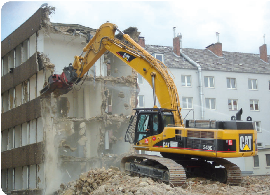
Grenzen der Bestandserhaltung von Gebäuden: Abriss und Neubau in Aachen
