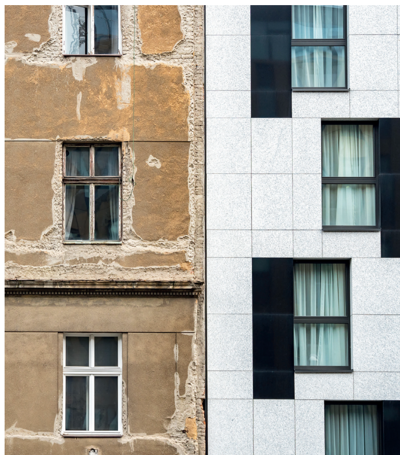
▲ Abb. 17: Heruntergekommenes und saniertes Haus nebeneinander © AdobeStock_192241259
