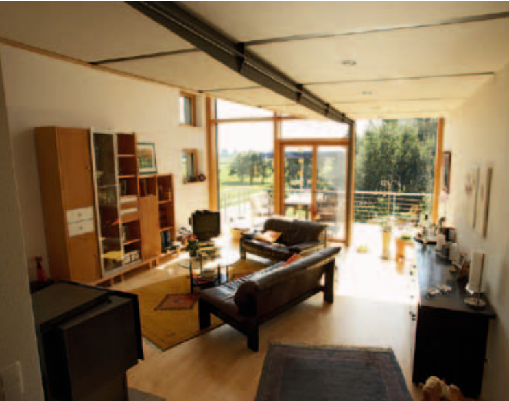
Holzpelletofen, Passivhaus Hendelkens, Hückelhoven
