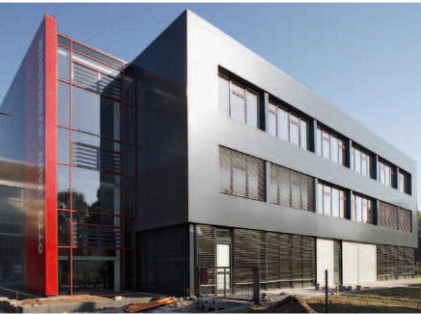
Gymnasium in Massivbauweise, Dinslaken
