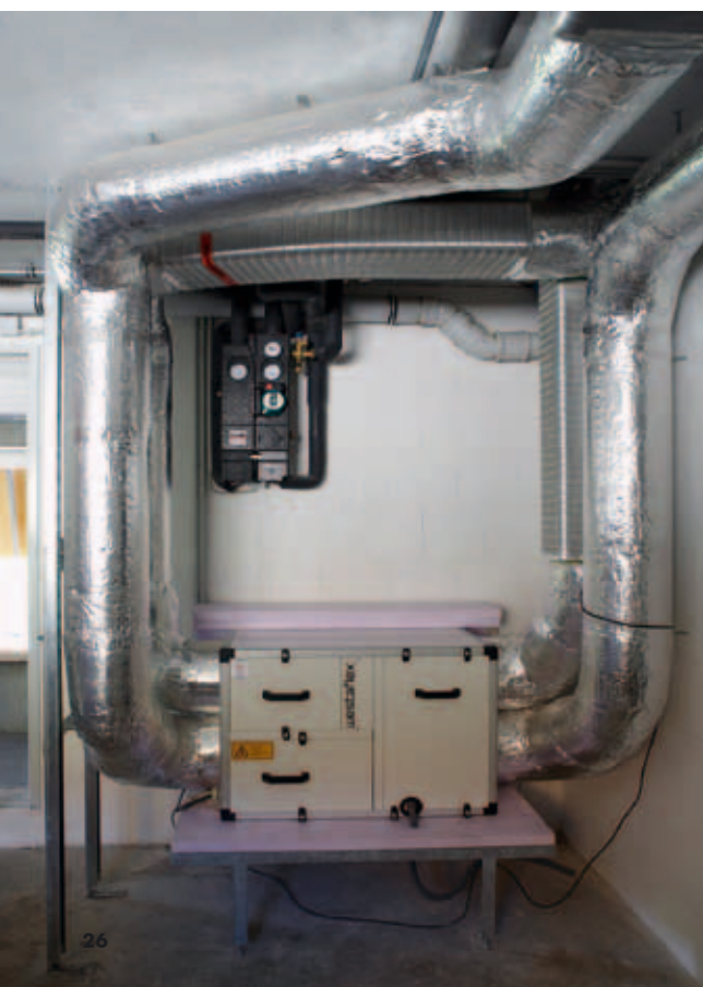
Lüftungsanlage im Passivhaus Berenbrink, Rietberg
