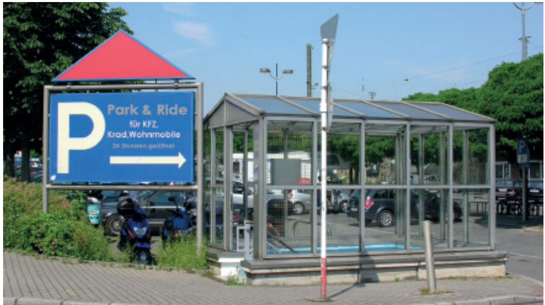
Park-and-Ride-Anlage mit Fahrradparkplatz in Bahnhofsnähe
