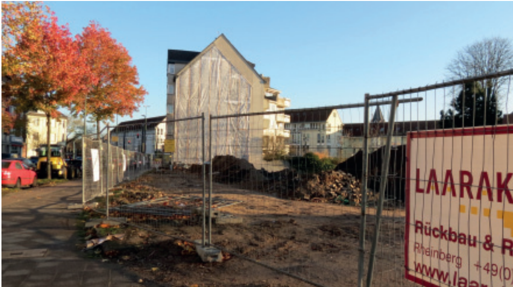
Rückbaumaßnahme in Mehrfamilienhausgebiet
