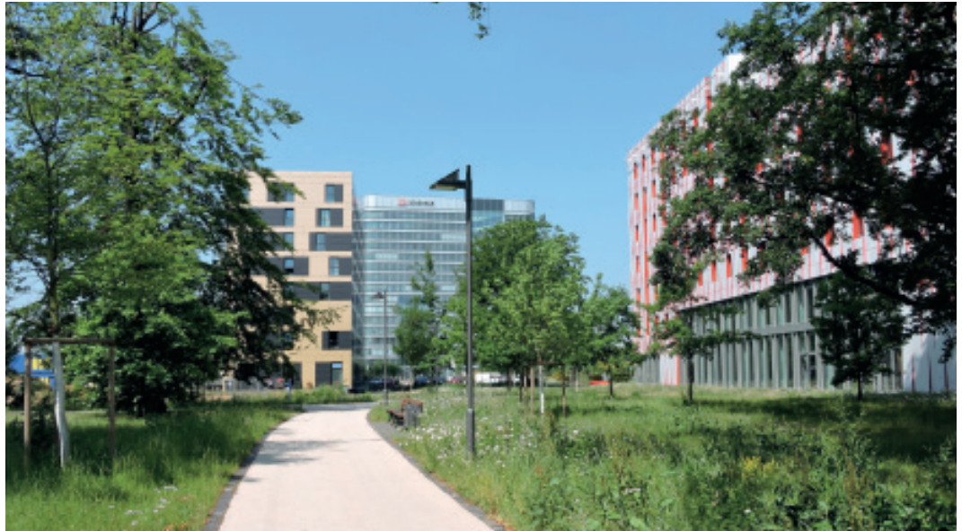
Business-Park am Flughafen Frankfurt/Main (Gateway Gardens)
